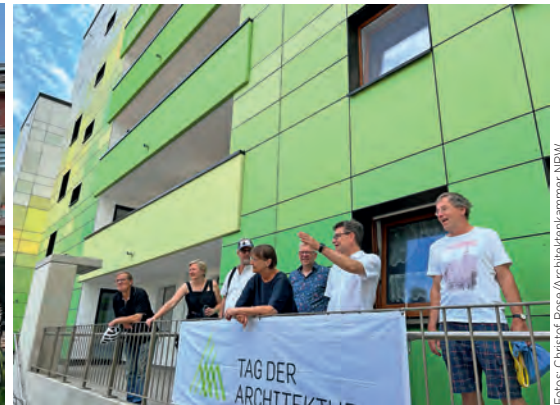
Sozial wichtige und planerisch fordernde Bauaufgabe: Architekt Dirk Druschke (2. v. r.) erläuterte die energetische Sanierung des „Citywohnparcs“ mit 400 WE in Duisburg.
